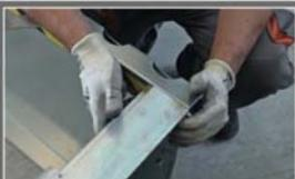
La nuova cassaforma ha un telaio facilmente preassemblabile, i pezzi sono preparati per limitare i tempi e soprattutto i costi d'installazione.
