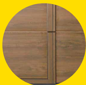
Dettaglio vista esterna
